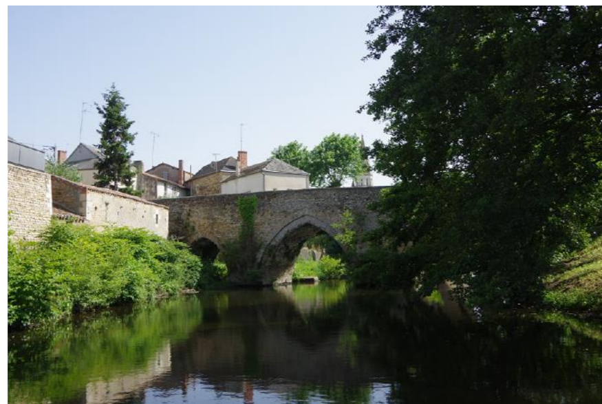
Photo 105 : Ancien pont (MH1) dans le fond de vallée du Thouaret
